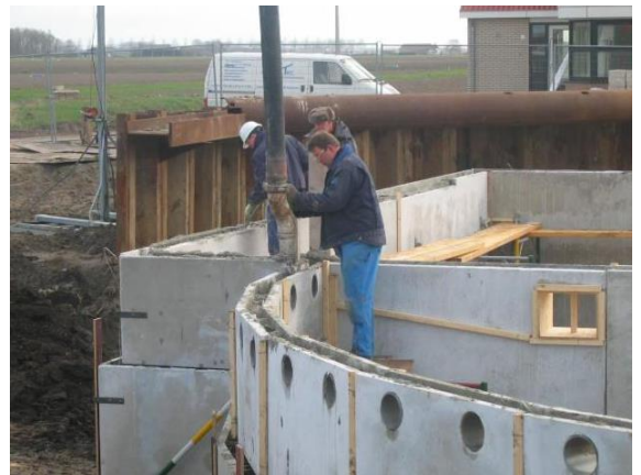
Figuur 10: Volstorten holle betonwand
