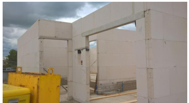
Figuur 12: Ingemetselde betonlatei
