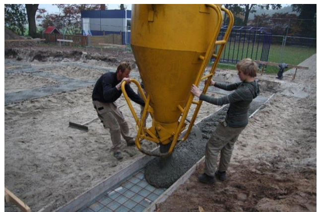
Figuur 1: Beton storten op de bouwplaats
