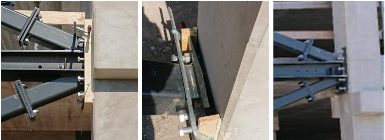
figuur 1-3 Kist om verbinding tussen staal-beton die na het vullen en uitharden verwijderd is
